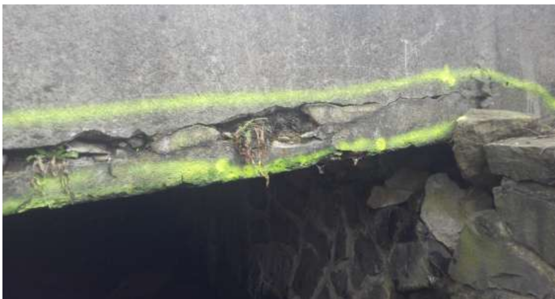
Obr. č. 2 - Degradovaná římsa na protivodní straně
