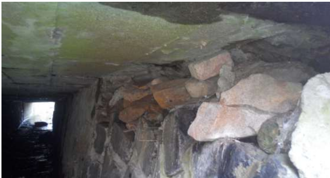
Obr. č. 3 - Rozebrané uložení desky na pravobřežní straně opěry
