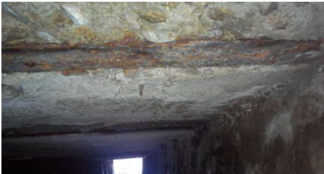
Obr. č. 1. Korodující spodní pásnice ocelové podpěry
